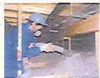
天井の断熱改修
